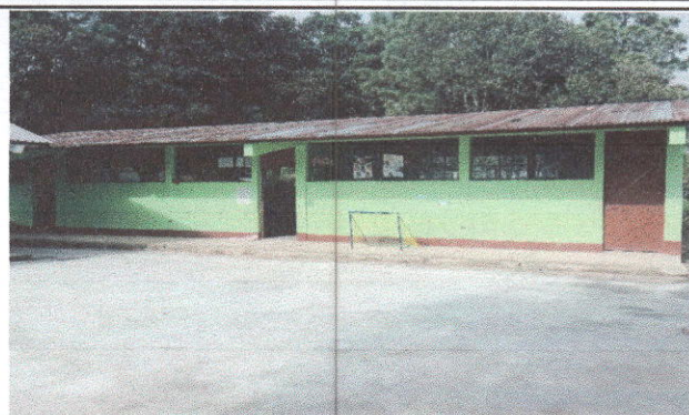
Foto 2: Puertas de metal. Mantenimiento aplicación de pintura
