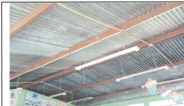
Foto1: Reparacion del sistema electrico .
