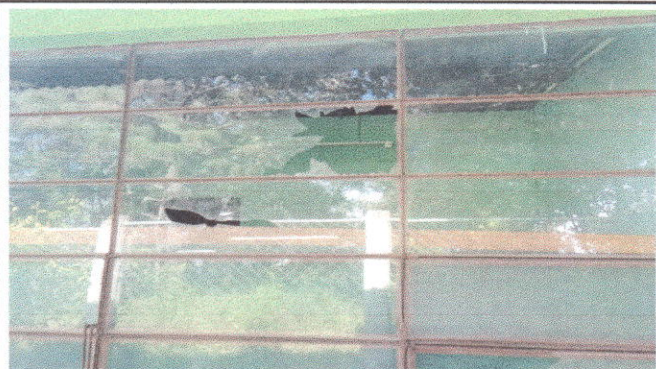
Foto 3: Ventanas. Sustitución de vidrios.
