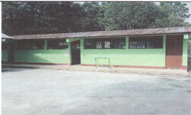
Foto1: Cubierta de lámina de módulo de aulas.
